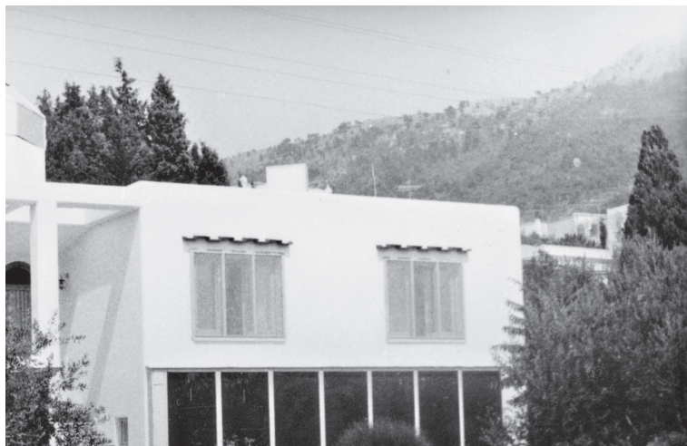
Solobservatoriet på Capri. Lägg märke till solfångarna under fönstren. Foto: Yngve Öhmans arkiv, KVA Centrum för vetenskapshistoria.
